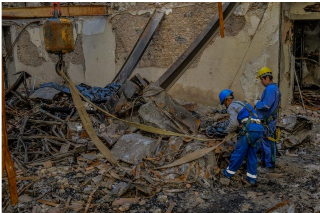
Imagem 02: Retirada dos entulhos por guindaste.
