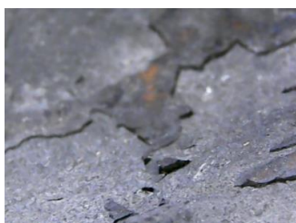
Imagens 27 e 28: Laminado e delaminando.
